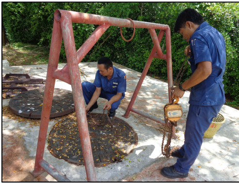
ภาพที่ 2-4 เจ้าหน้าที่ดูแลระบบบำบัดน้ำเสีย / ตักไขมัน
